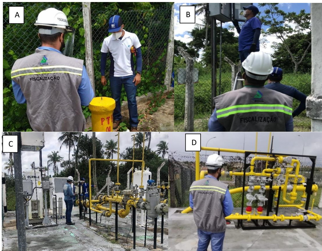
Figura 7 – Verificação do sistema de proteção catódica na (A) estação de regulação e pressão (ERP) DIA; (B) Retificador de Estância; (C) estação de transferência de custódia (ETC) Estância e (D) estação de transferência de custódia (ETC) Manguinhos, em Aracaju
