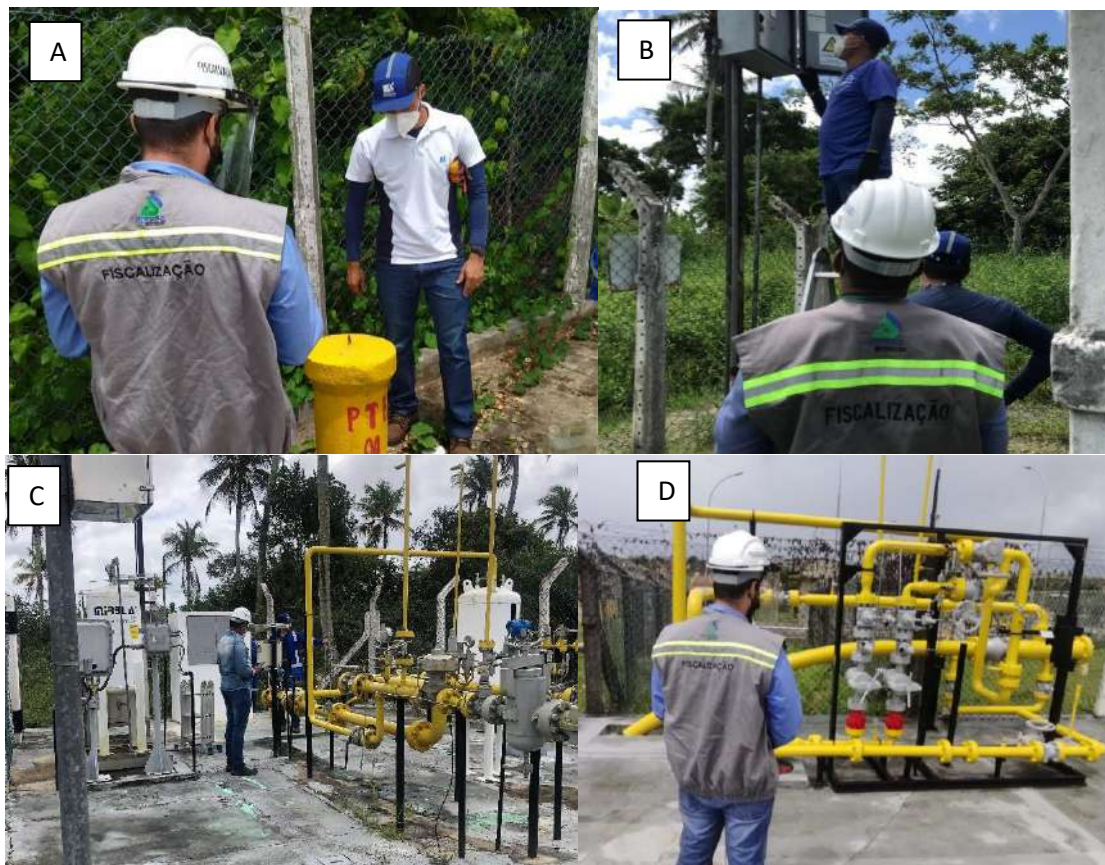
Figura 7 – Verificação do sistema de proteção catódica na (A) estação de regulagem e pressão (ERP) DIA; (B) Retificador de Estância; (C) estação de transferência de custódia (ETC) Estância e (D) estação de transferência de custódia (ETC) Mangueiros, em Aracaju
