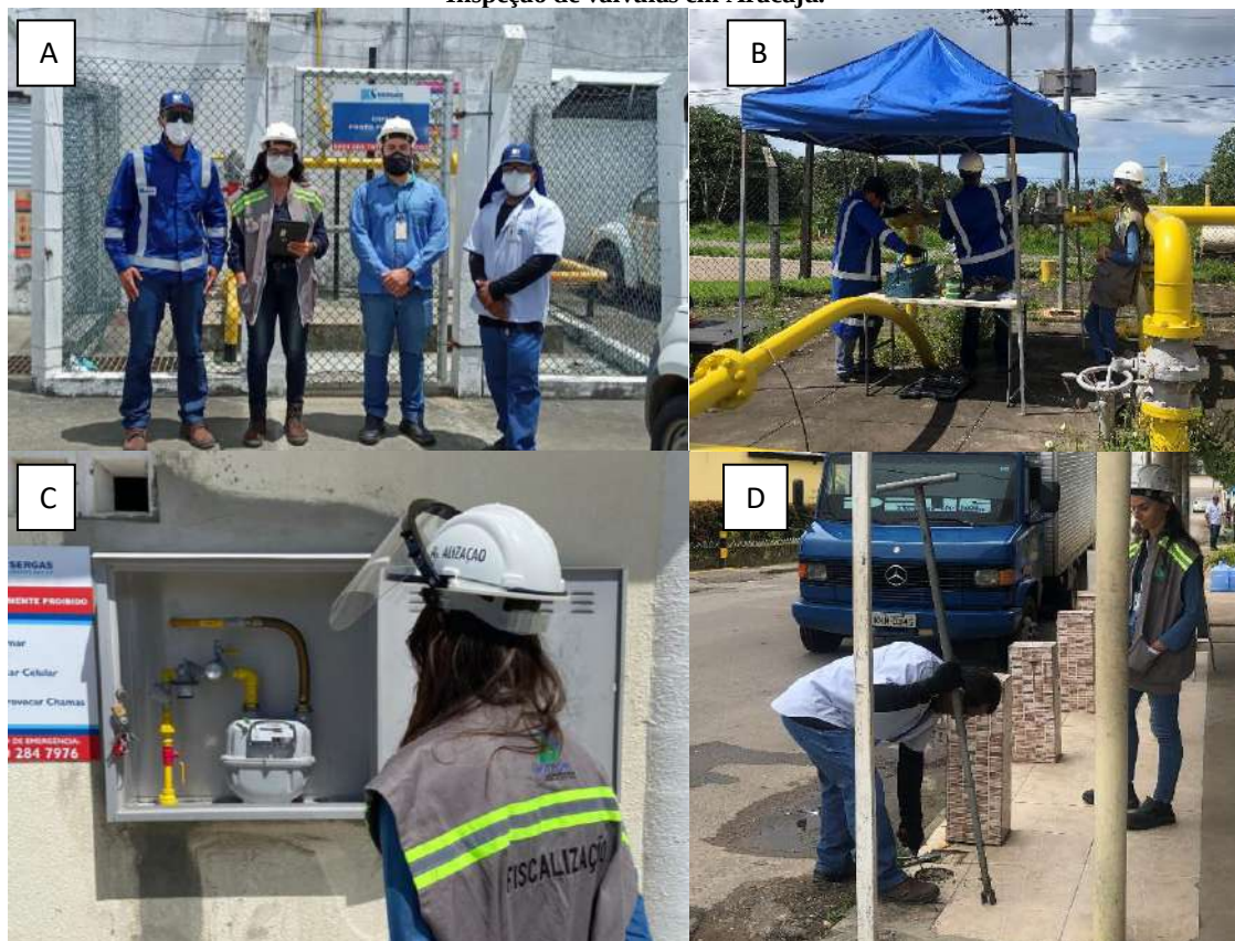
Figura 5 - (A) Substituição de medidor de vazão na estação de regulação de pressão e medição (ERPM) Posto Piranema; (B) Substituição dos componentes internos da rede da estação de regulação de pressão e medição (ERPM) DIE II; (C) Inspeção do Conjunto de Regulação e Medição (CRM) dos usuários em Aracaju e (D) Inspeção de válvulas em Aracaju.
