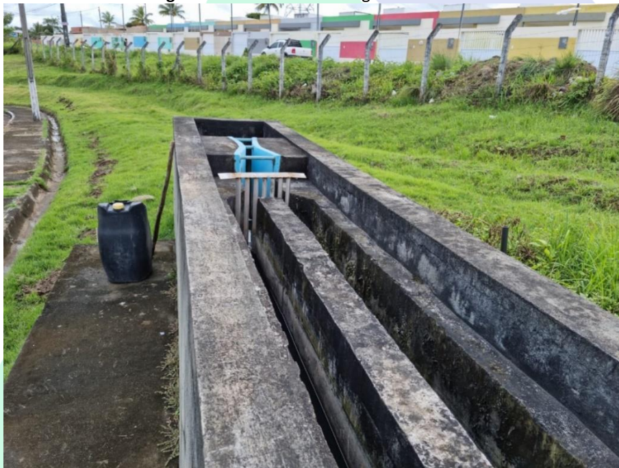
Imagem 02: ETE Socorro - Chegada do efluente.
