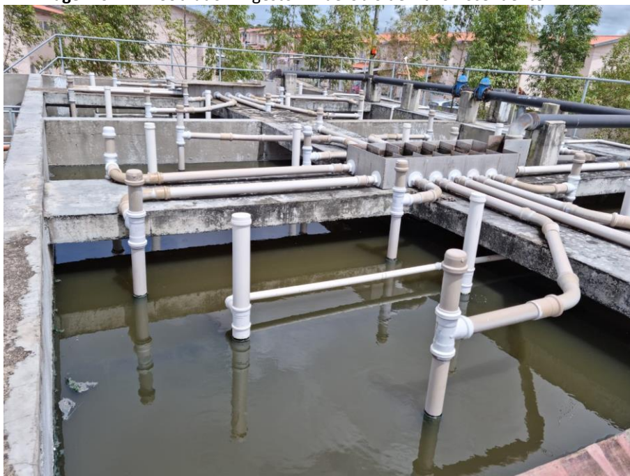
Imagem 07: ETE Sobrado - Digestor Anaeróbio de Fluxo Ascendente – DAFA.
