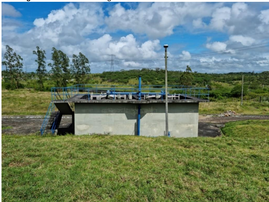
Imagem 03: ETE Socorro – Digestor Anaeróbio de Fluxo Ascendente – DAFA.
