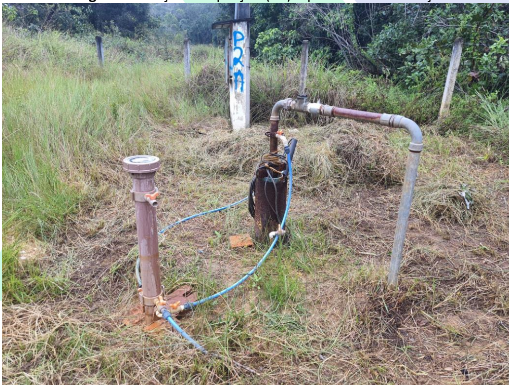
Imagem 4 – Poço de captação (P2) e ponto de desinfecção.
