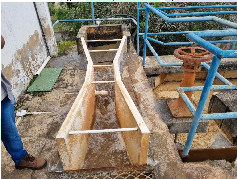
Imagem 8 – Calha parshall da ETA Propriá.
