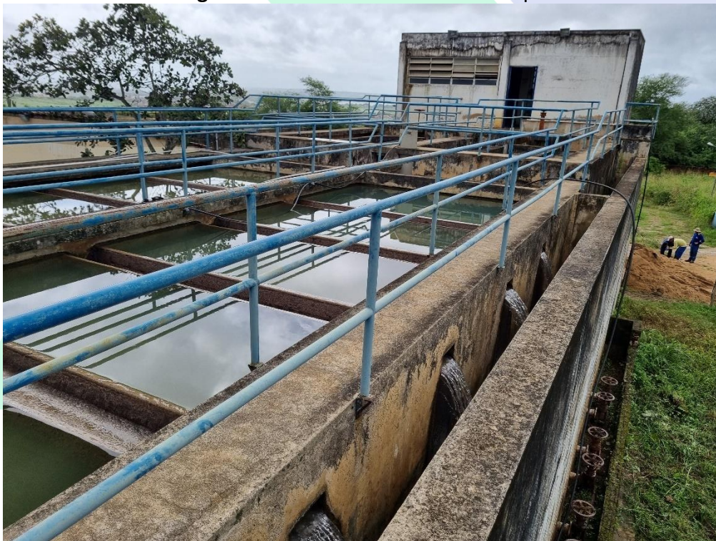
Imagem 10 – Decantadores da ETA Propriá.
