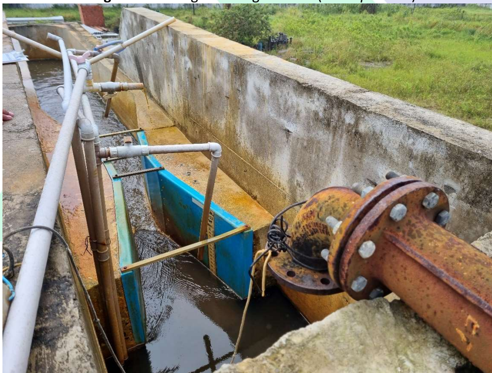
Imagem 12 – Chegada da água bruta (Calha parshall).
