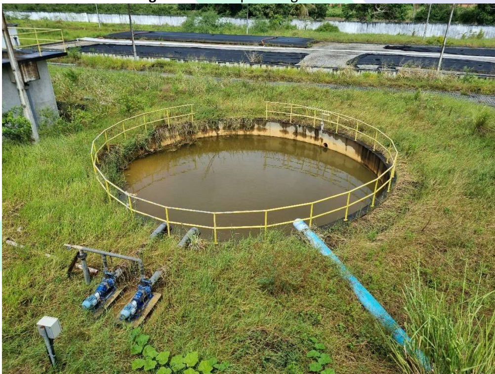
Imagem 18 – Tanque de água de reuso.
