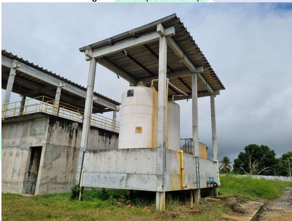
Imagem 16 – Tanque sulfato Líquido.
