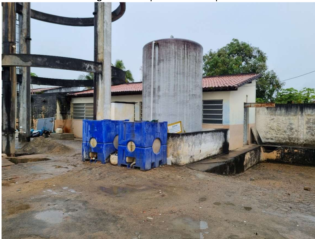
Imagem 6 – Tanque de sulfato líquido.
