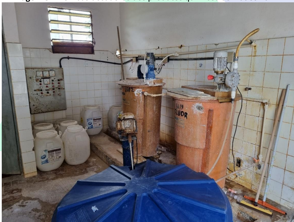
Imagem 5 – Bombas dosadoras dos produtos químicos utilizados na ETA.
