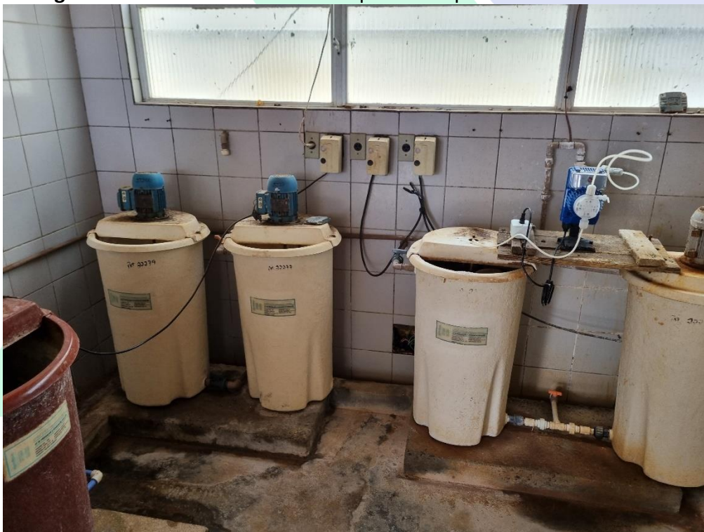
Imagem 11 – Bombas dosadoras dos produtos químicos utilizados na ETA.
