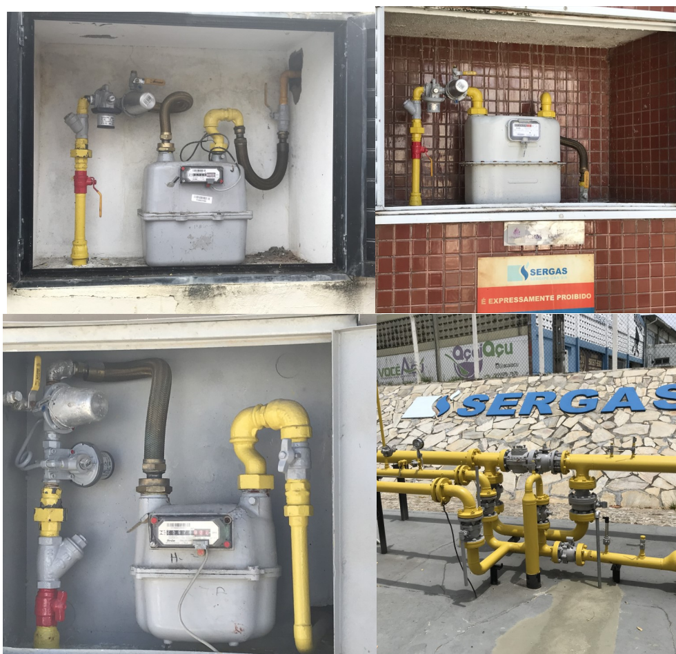
Figura 1: Obra para substituição da válvula de retenção
