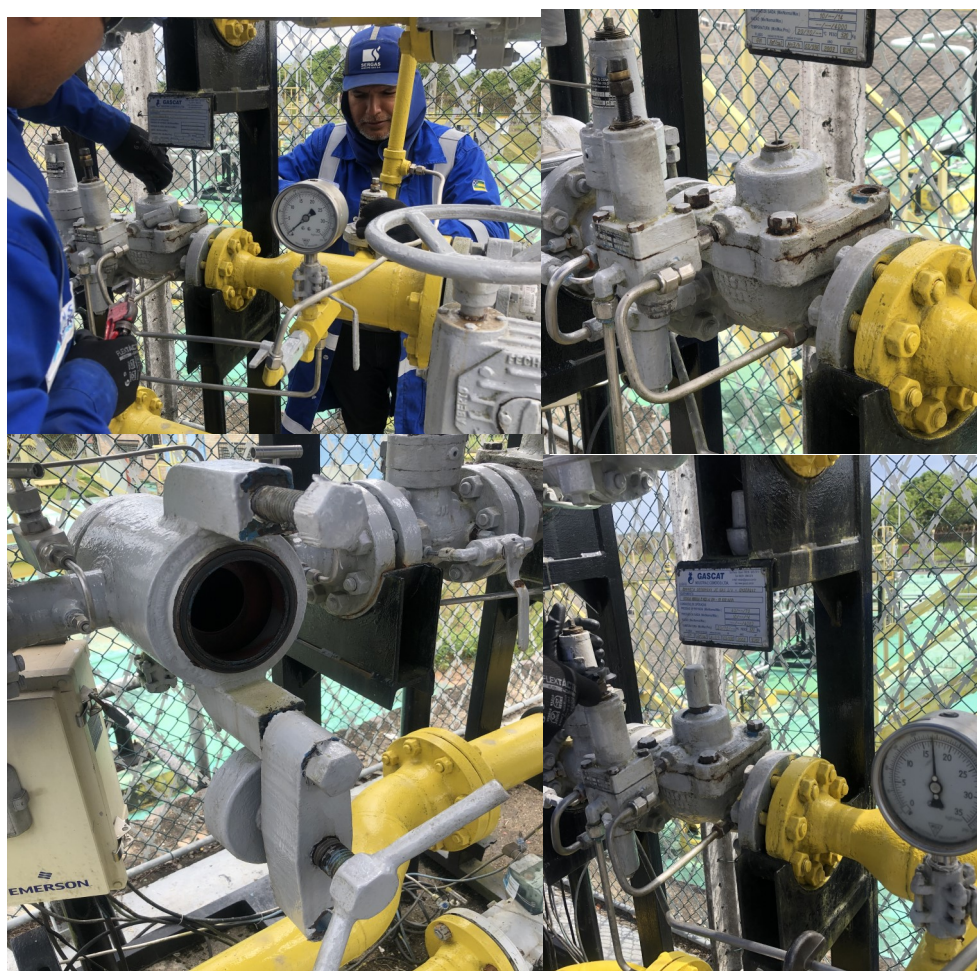
Figura 1 : Obra para substituição da válvula de retenção
