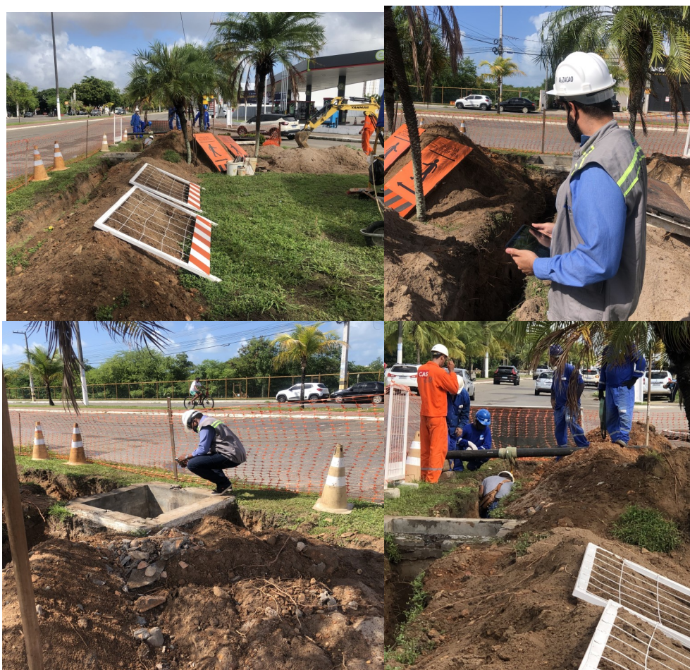
Figura 1 : Obra para substituição da válvula de retenção
