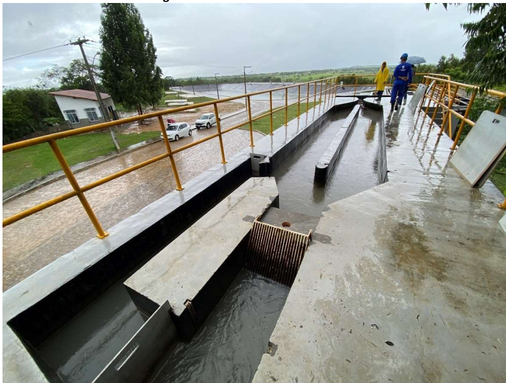
Imagem 2 – Gradeamento e caixa de Areia
