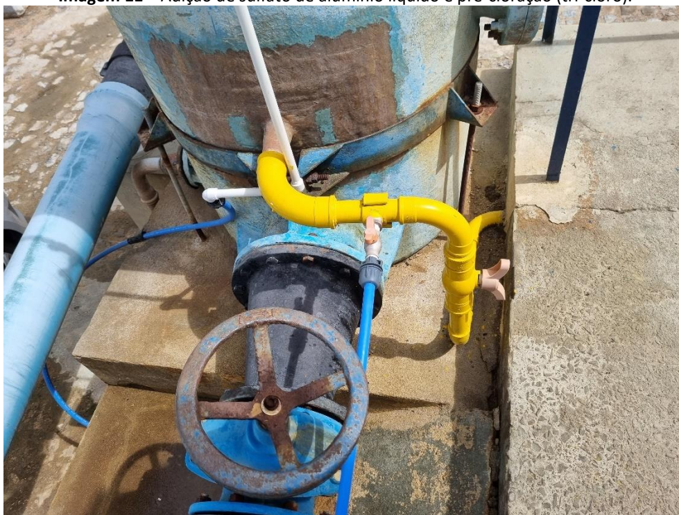
Imagem 11 – Adição de sulfato de alumínio líquido e pré-cloração (tri-cloro).
