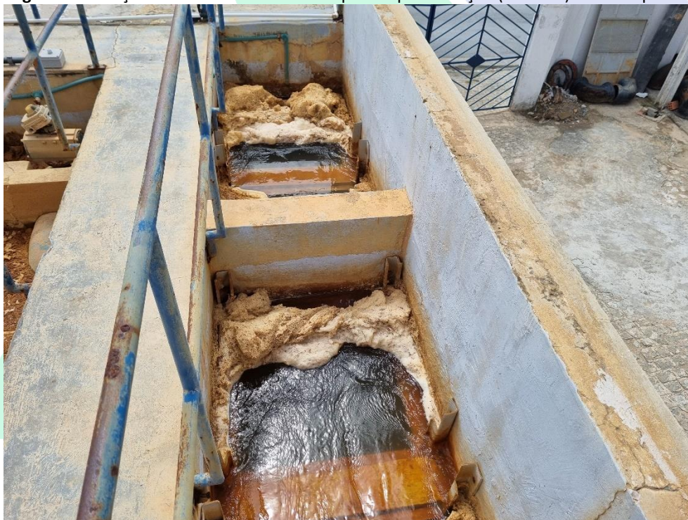
Imagem 07 – Adição de sulfato de alumínio líquido e pré-cloração (tri-cloro) na calha parshall.
