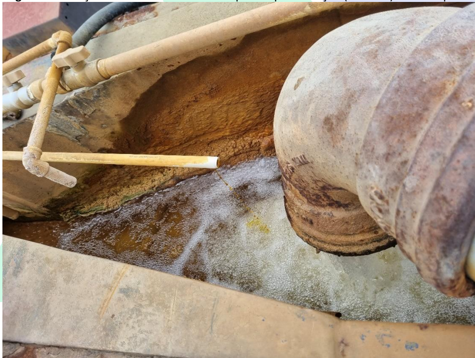
Imagem 02 – Adição de sulfato de alumínio líquido e pré-cloração (tri-cloro) na calha parshall.
