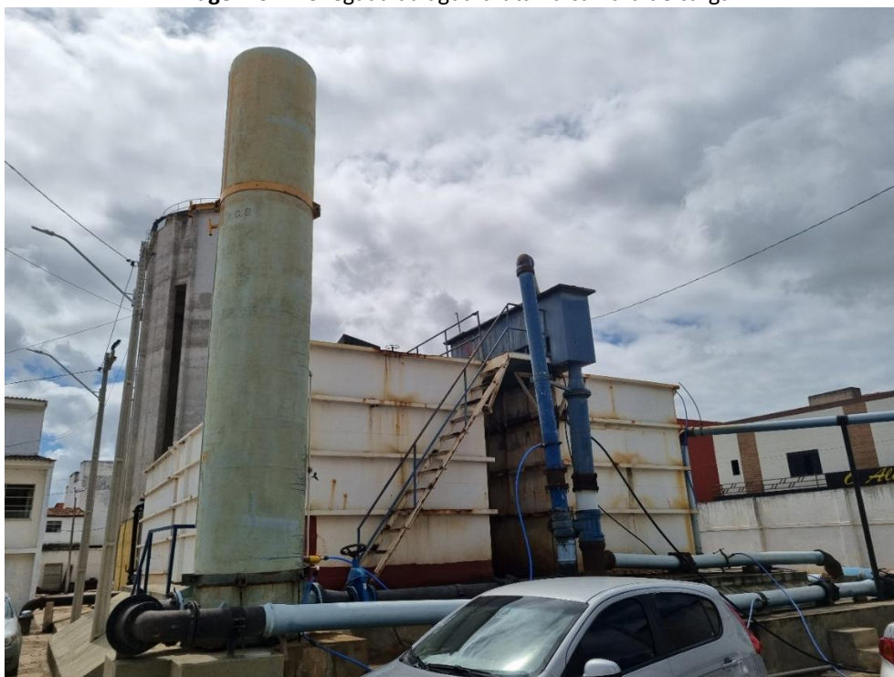
Imagem 01 – Chegada da água bruta na câmara de carga.
