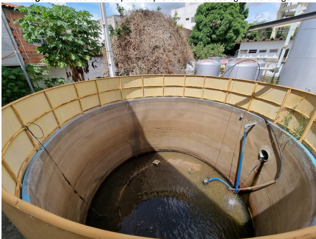
Imagem 3 – Reservatório para reaproveitamento das águas de lavagem.
