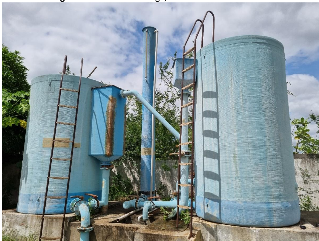
Imagem 10 – Câmara de carga, clarificador e filtro da ETA.
