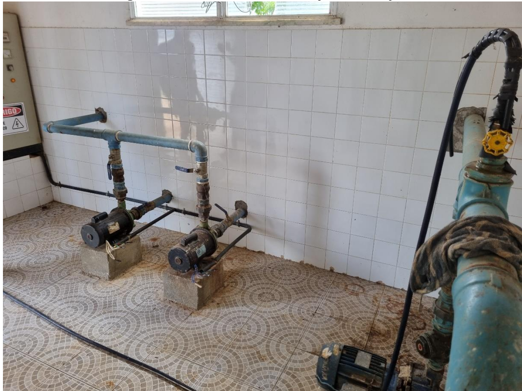
Imagem 12 – Bombas de distribuição e elevação.
