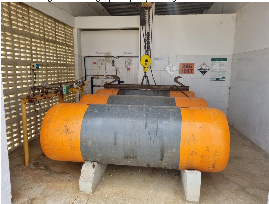
Imagem 5 – Cloro gás para aplicação na água tratada do RAP.
