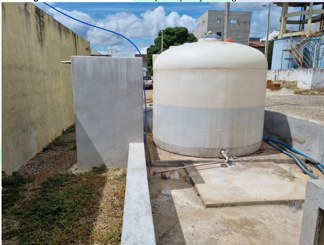
Imagem 6 – Reservatório do flúor para aplicação na água tratada do RAP.
