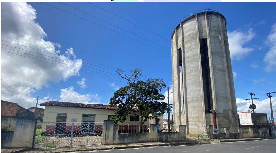
Imagem 01 – Entrada da ETA.
