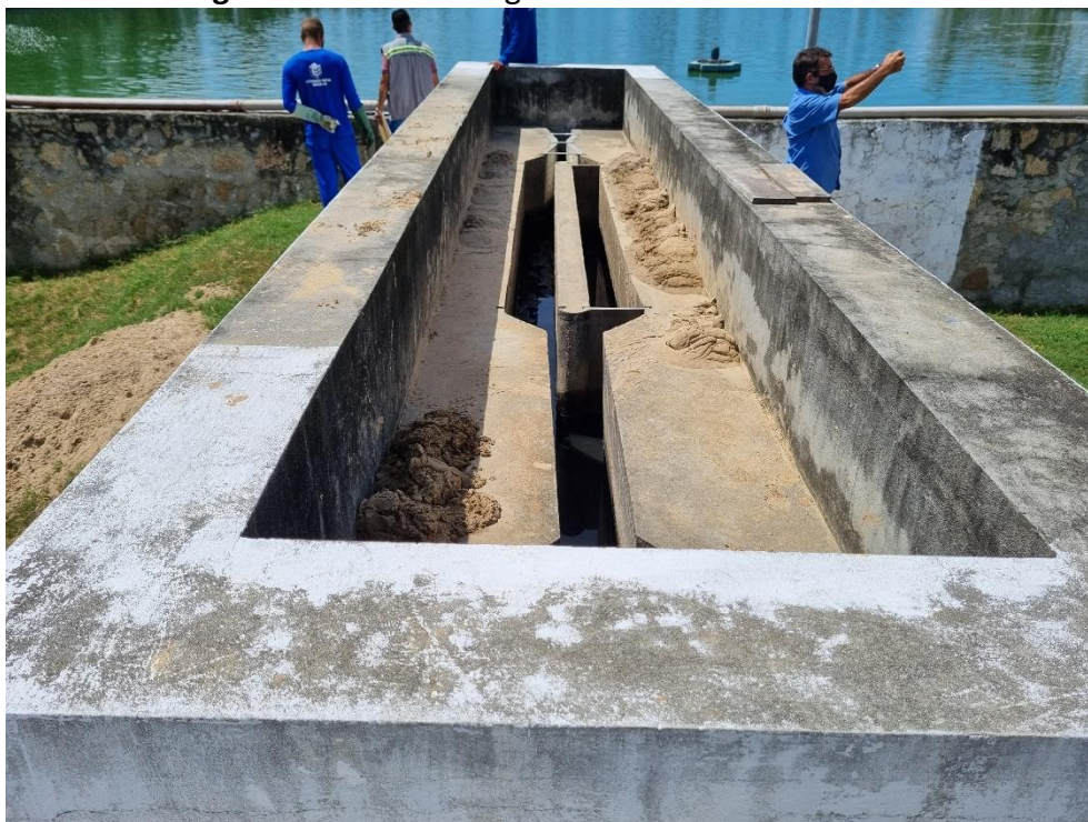
Imagem 4: Calha de chegada do efluente bruto na ETE.
