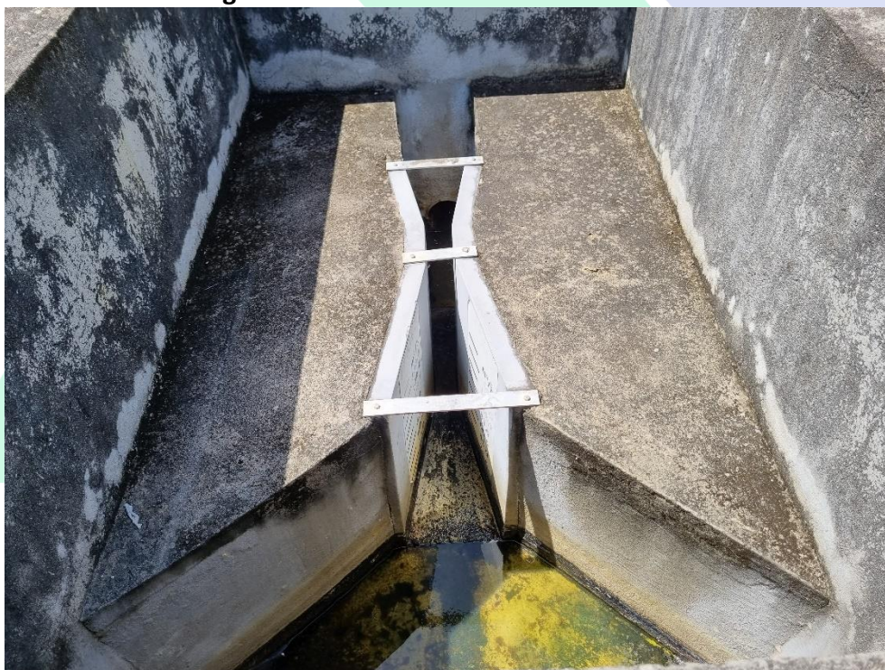
Imagem 7: Calha de saída do efluente tratado.
