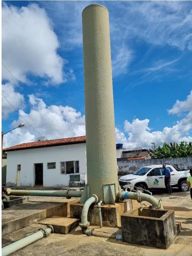
Imagem 02 – Chegada da água bruta na torre de elevação.
