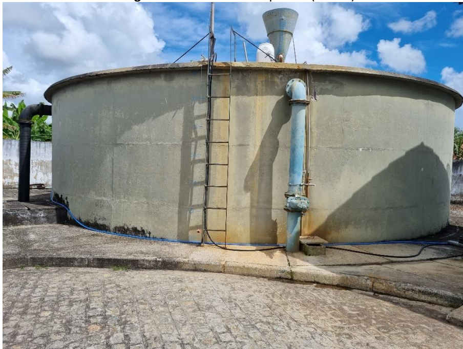
Imagem 04 – Reservatório apoiado (312m 3 ).
