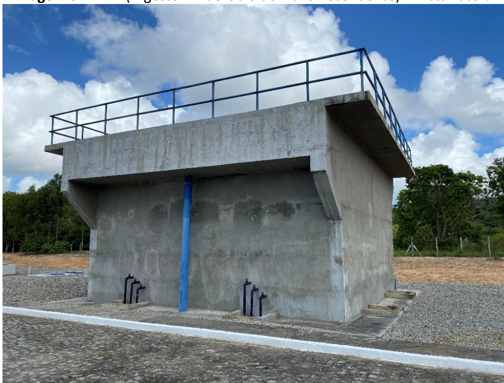
Imagem 3: DAFA (Digestor Anaeróbio de Fluxo Ascendente) – Vista Lateral.
