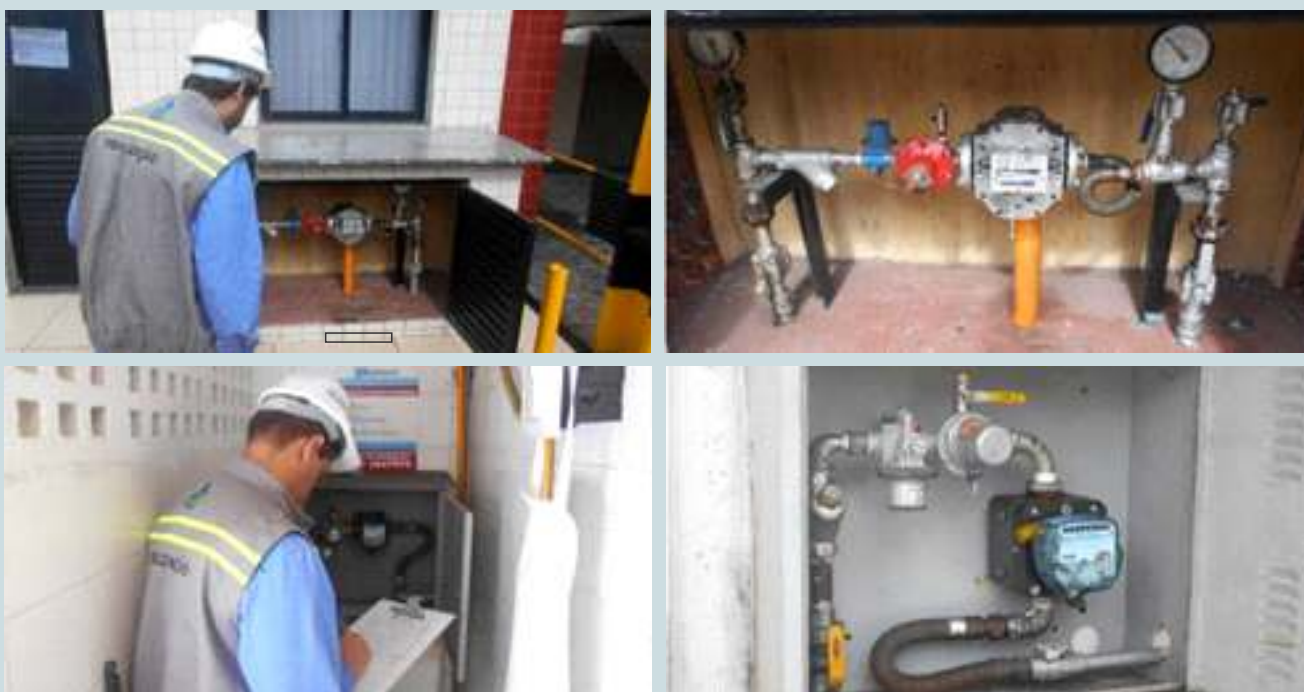
Figura 6: Fiscalização em medidores de gás canalizado.
