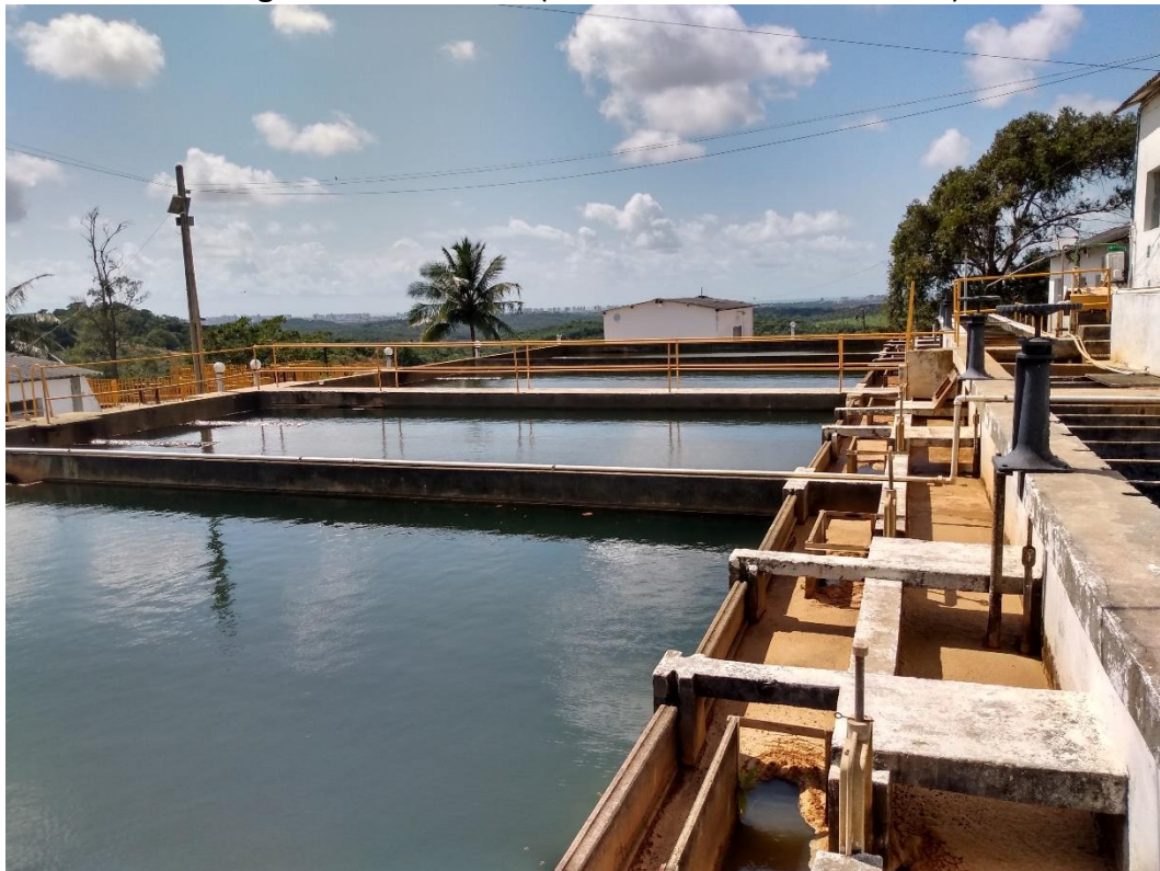
Imagem 1: ETA Cabrita (floculadores e decantadores).
