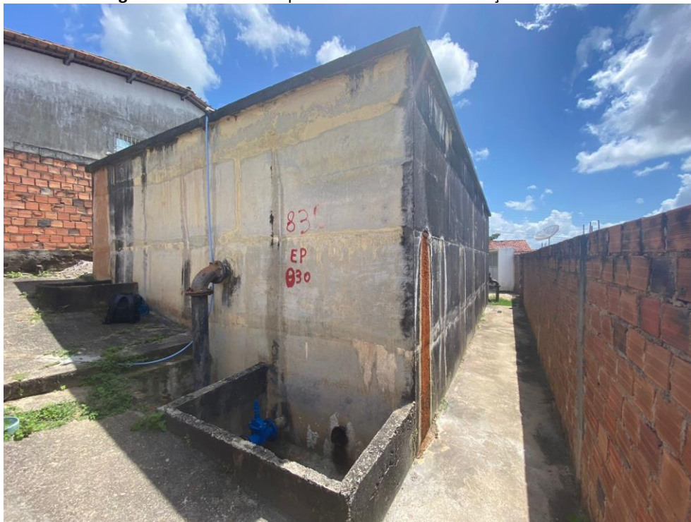
Imagem 5: Reservatório Apoiado e Unidade Desinfecção – Pacatuba.
