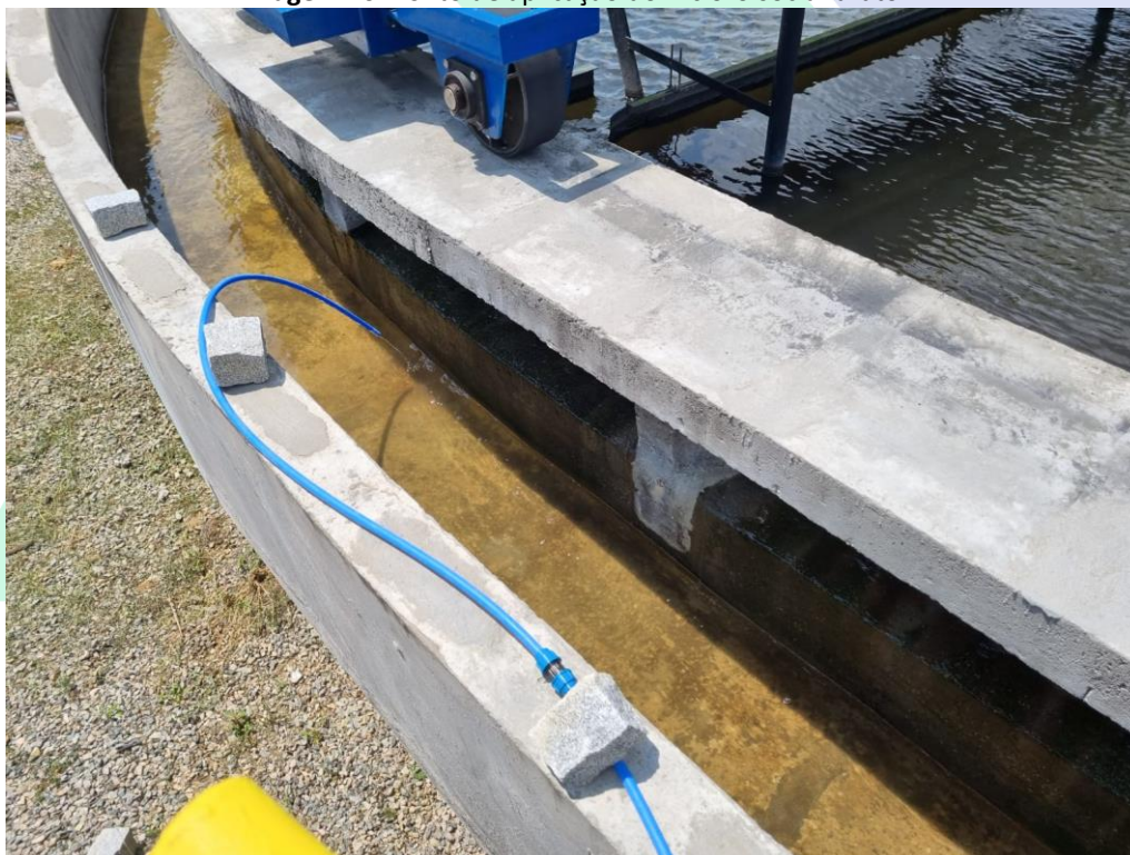
Imagem 10: Ponto de aplicação do Dicloroisocianurato.
