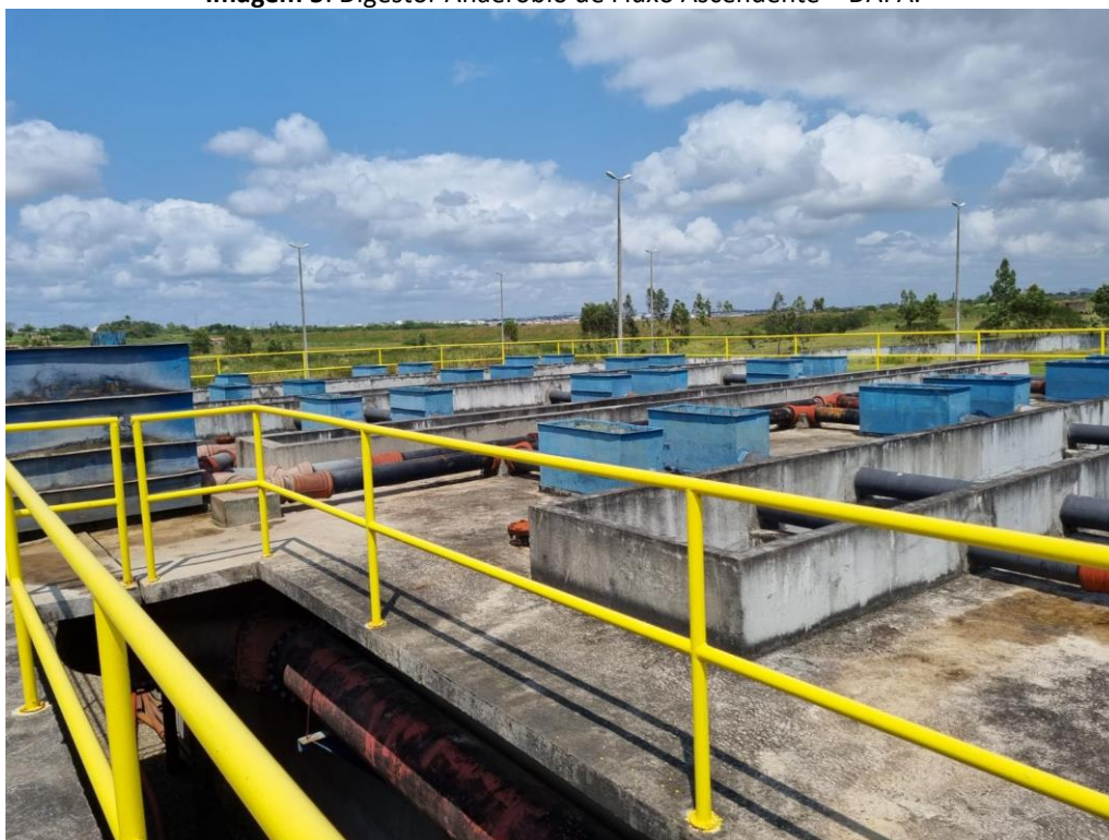
Imagem 5: Digestor Anaeróbio de Fluxo Ascendente – DAFA.
