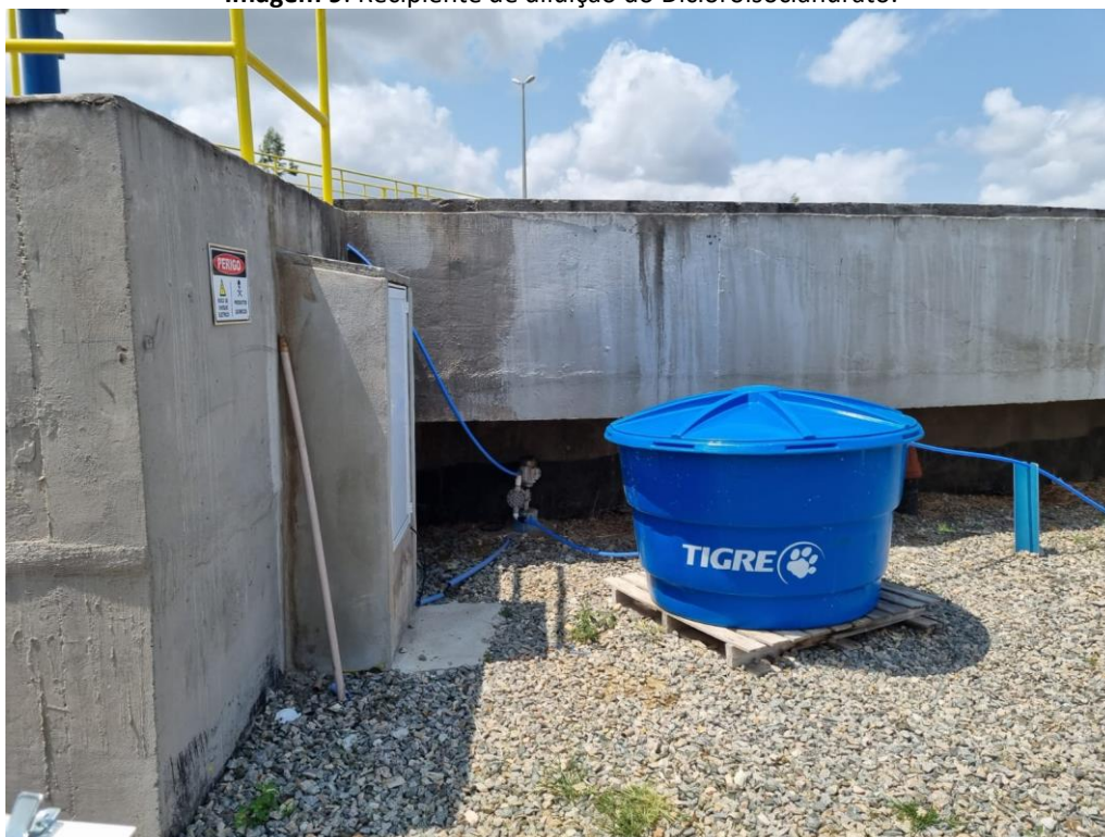
Imagem 9: Recipiente de diluição do Dicloroisocianurato.
