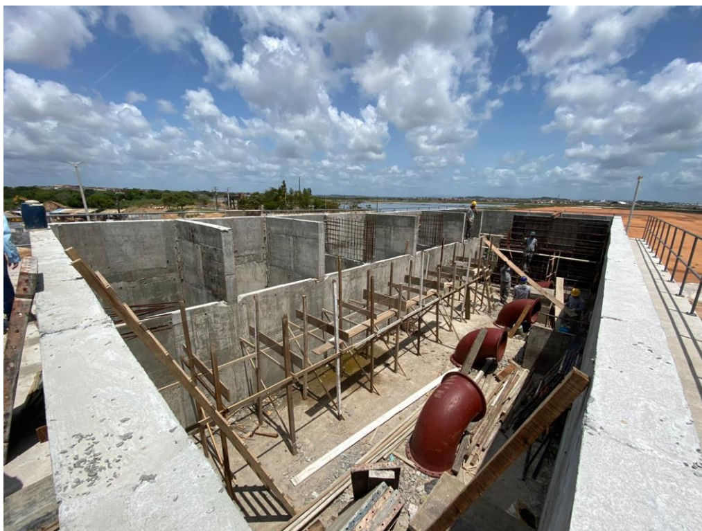
Imagem 7 – Nova estrutura de recebimento do efluente.
