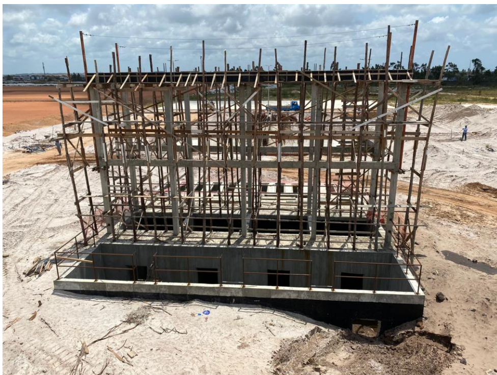
Imagem 9 – Nova estação elevatória de esgoto desarenado.
