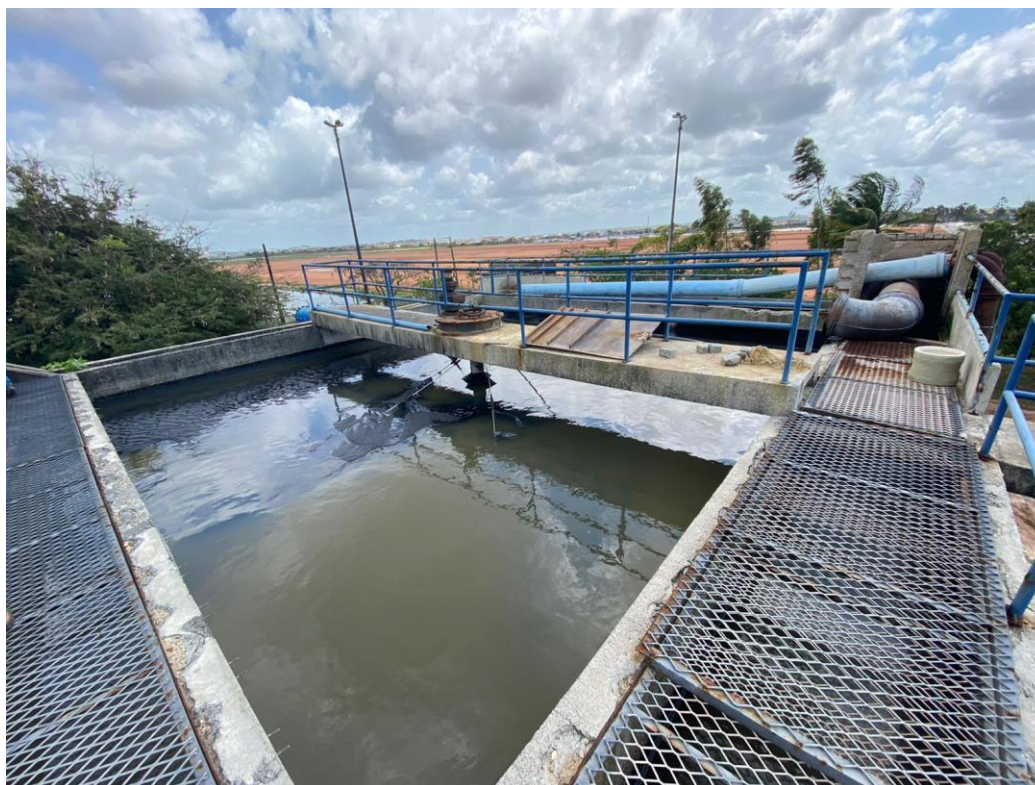
Imagem 3 – Estrutura desarenadora (visão superior).
