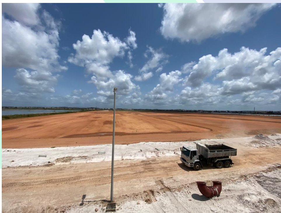
Imagem 10 – Terraplanagem da área de localização das novas lagoas.
