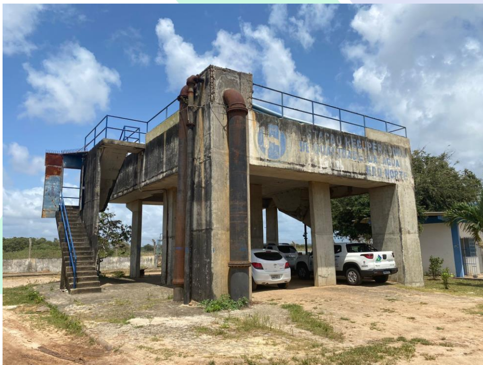
Imagem 2 – Estrutura desarenadora, de recebimento do efluente.
