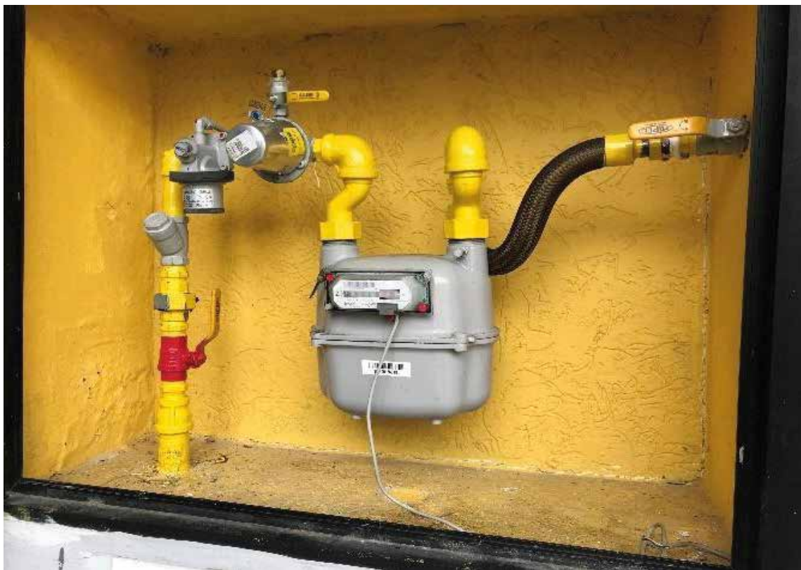
Figura 76 - Conjunto de regulação e medição.
