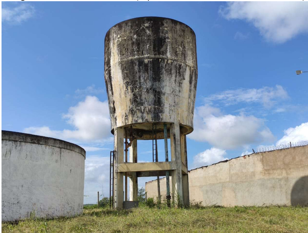
Imagem 3: Reservatório Elevado (capacidade de armazenamento de 100m 3 ).
