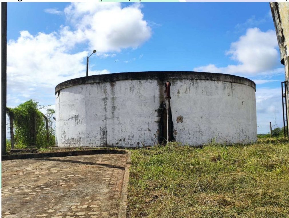
Imagem 2: Reservatório Apoiado (capacidade de armazenamento de 250m 3 ).
