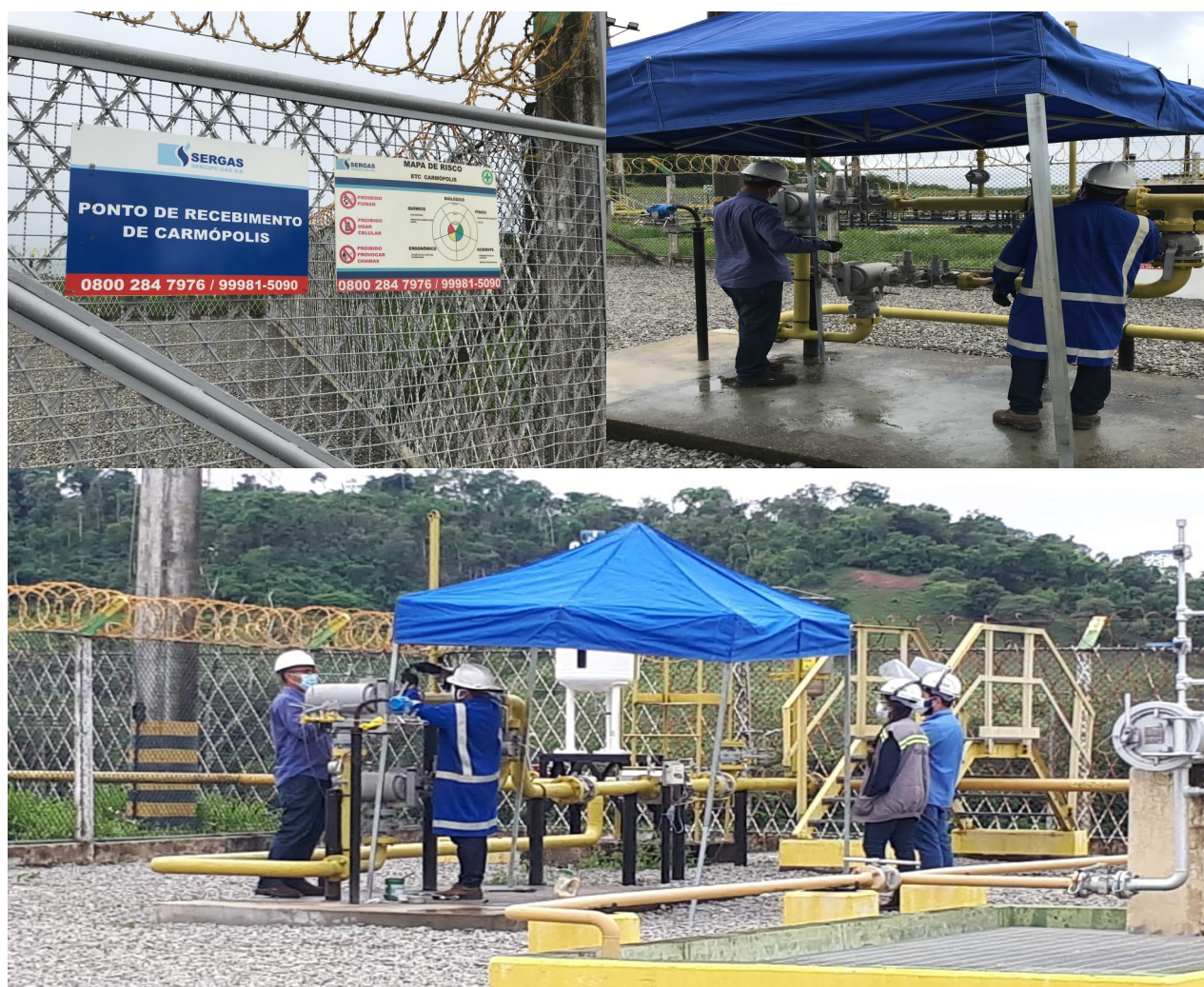
Figura 1: Manutenção na ETC Carmópolis
