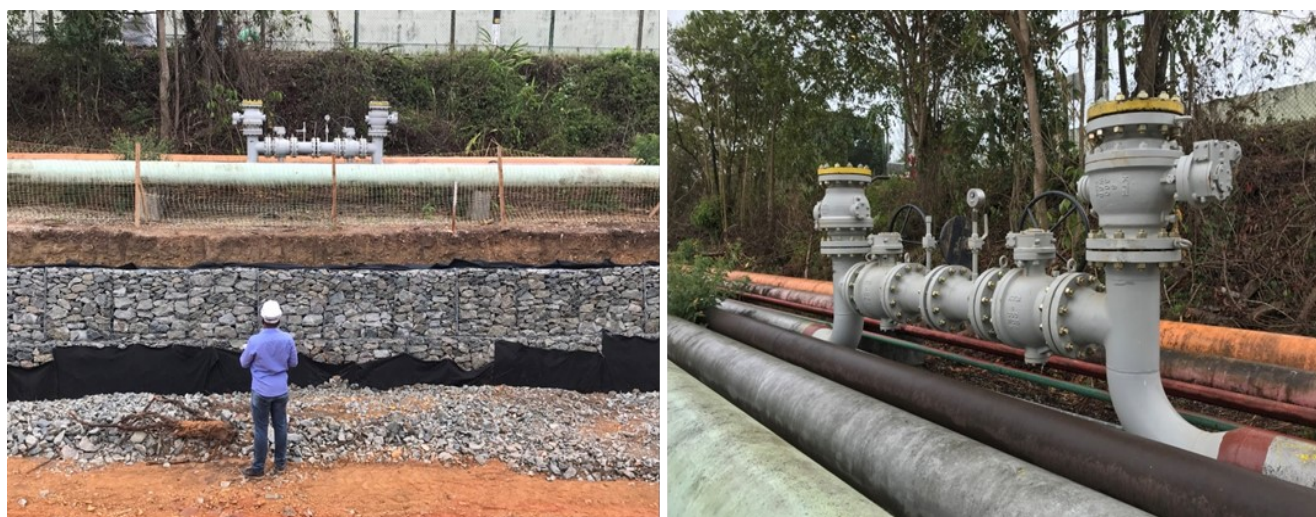
Figura 4: Estrutura de Válvulas predisposta para conexão da estação de medição
