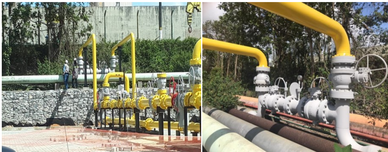
Figura 6: Conexão entre a estação de medição da SERGAS e o duto que supre a Proquiigel S.A.
