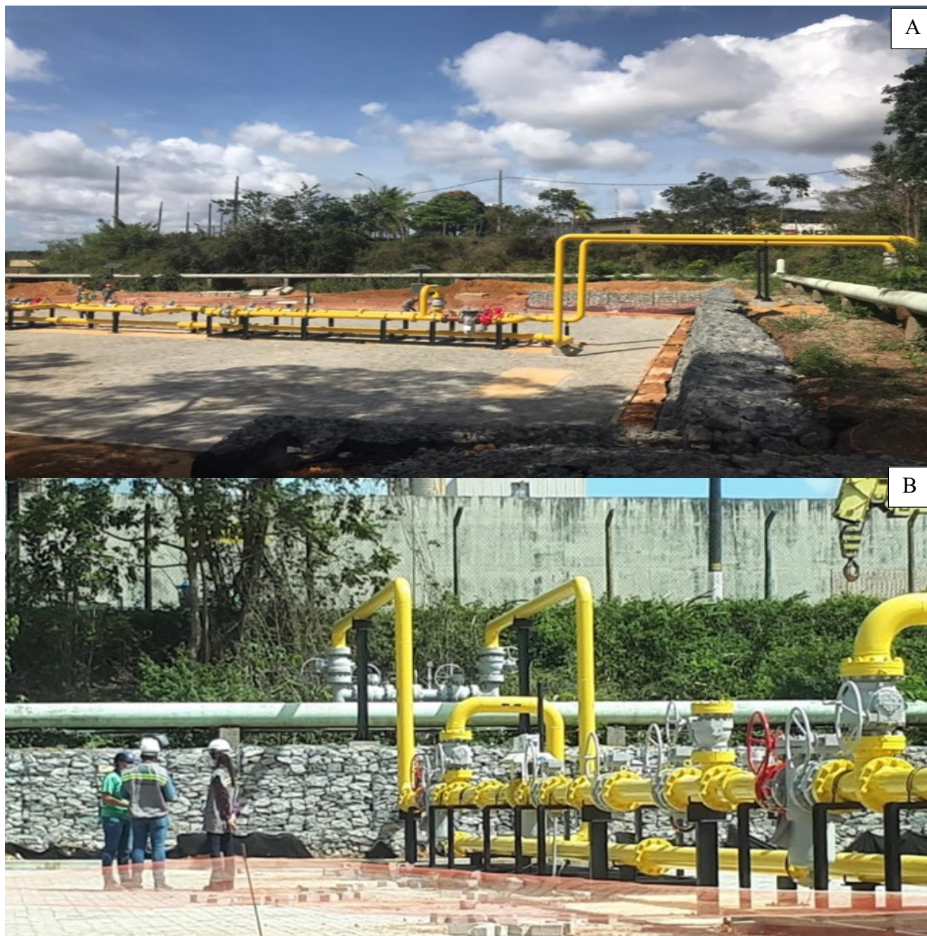
Figura 5: A - Praça da estação de medição, B- Estação de medição alocada.
