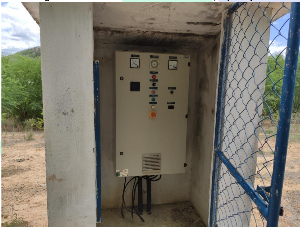
Imagem 7 – Quadro de comando da bomba de captação Cajueiro.
