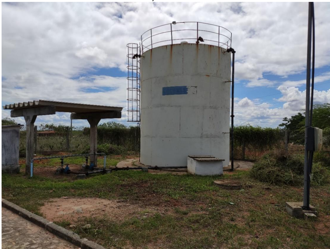
Imagem 10 – Reservatório Apoiado, assentamento Cajueiro – (Capacidade de armazenamento de 100m 3 ).
