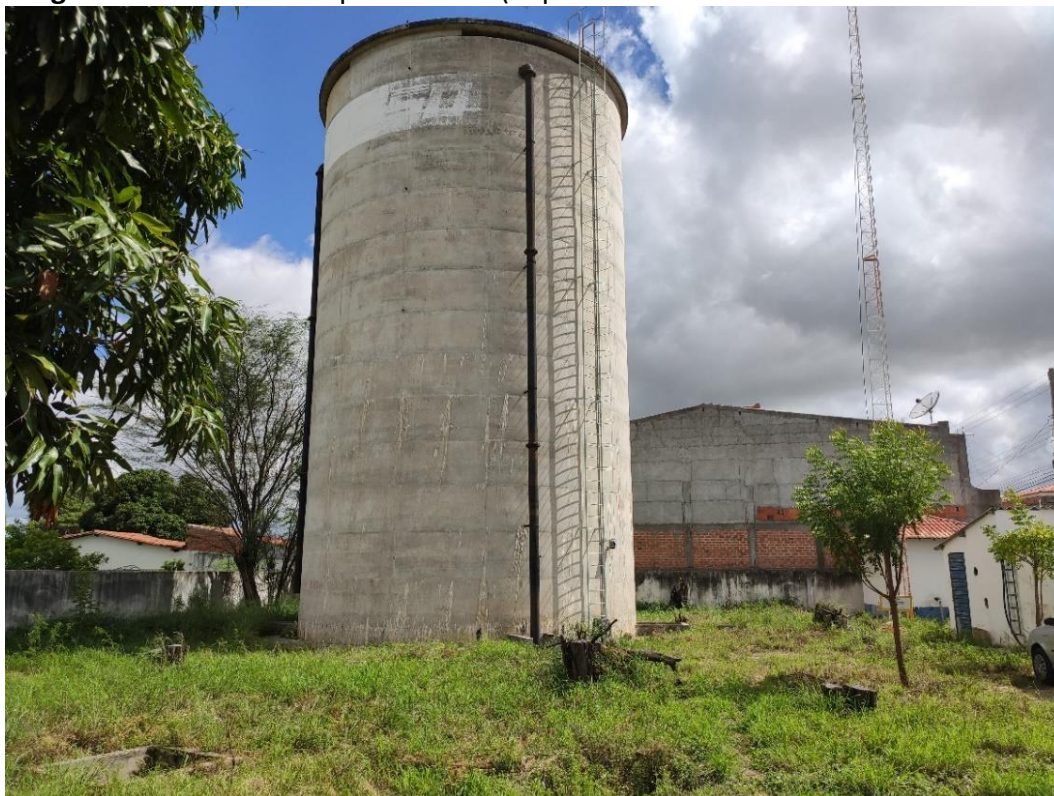
Imagem 2: Reservatório Apoiado 01 – (Capacidade de armazenamento de 900m 3 ).
