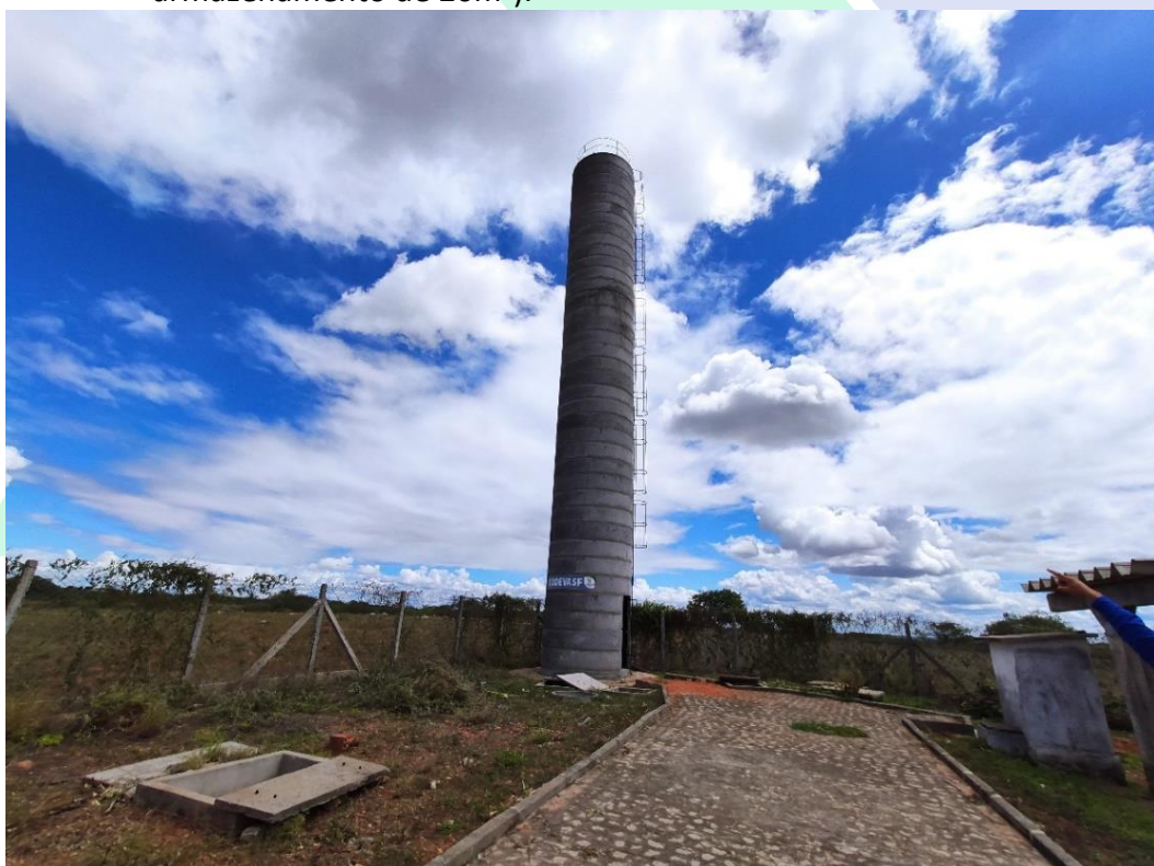
Imagem 11 – Reservatório Elevado, assentamento Cajueiro – (Capacidade de armazenamento de 20m 3 ).
