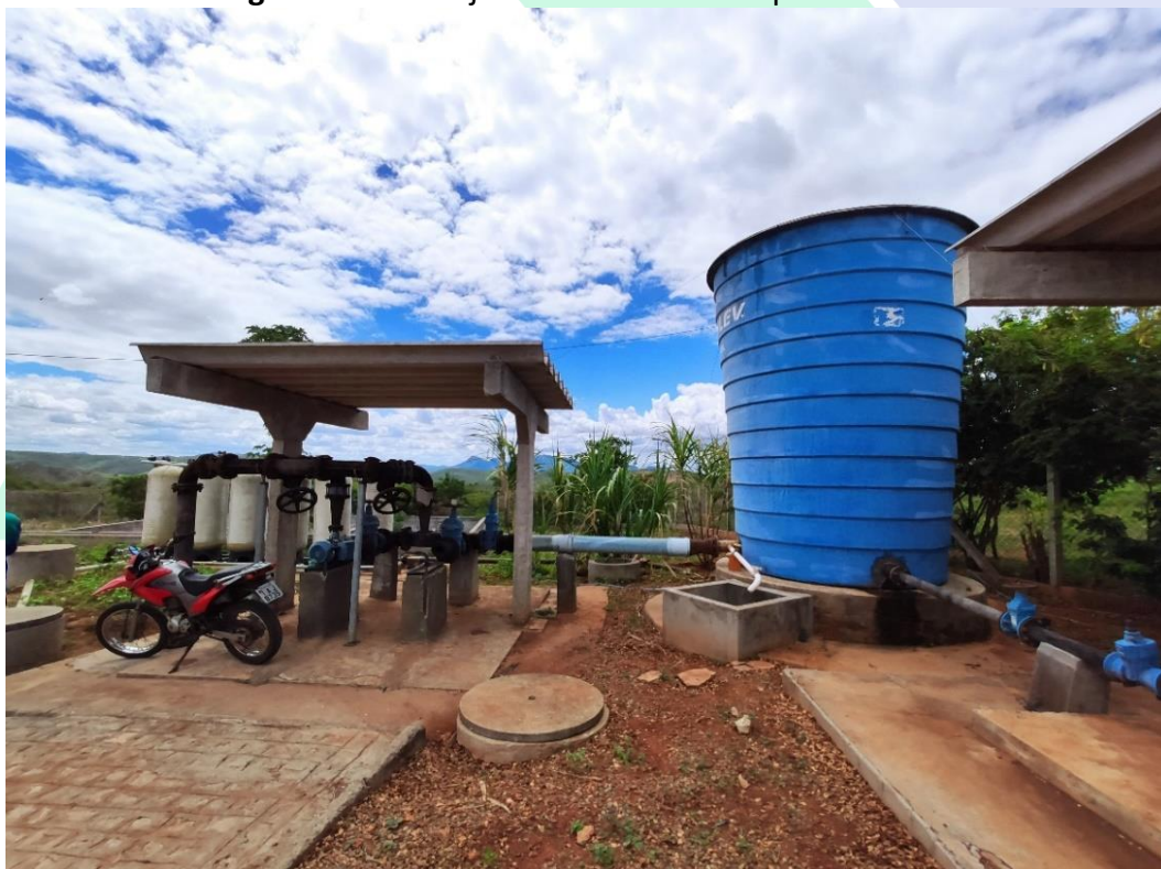
Imagem 9 – ETA Cajueiro – Filtros e Tanque de contato.
