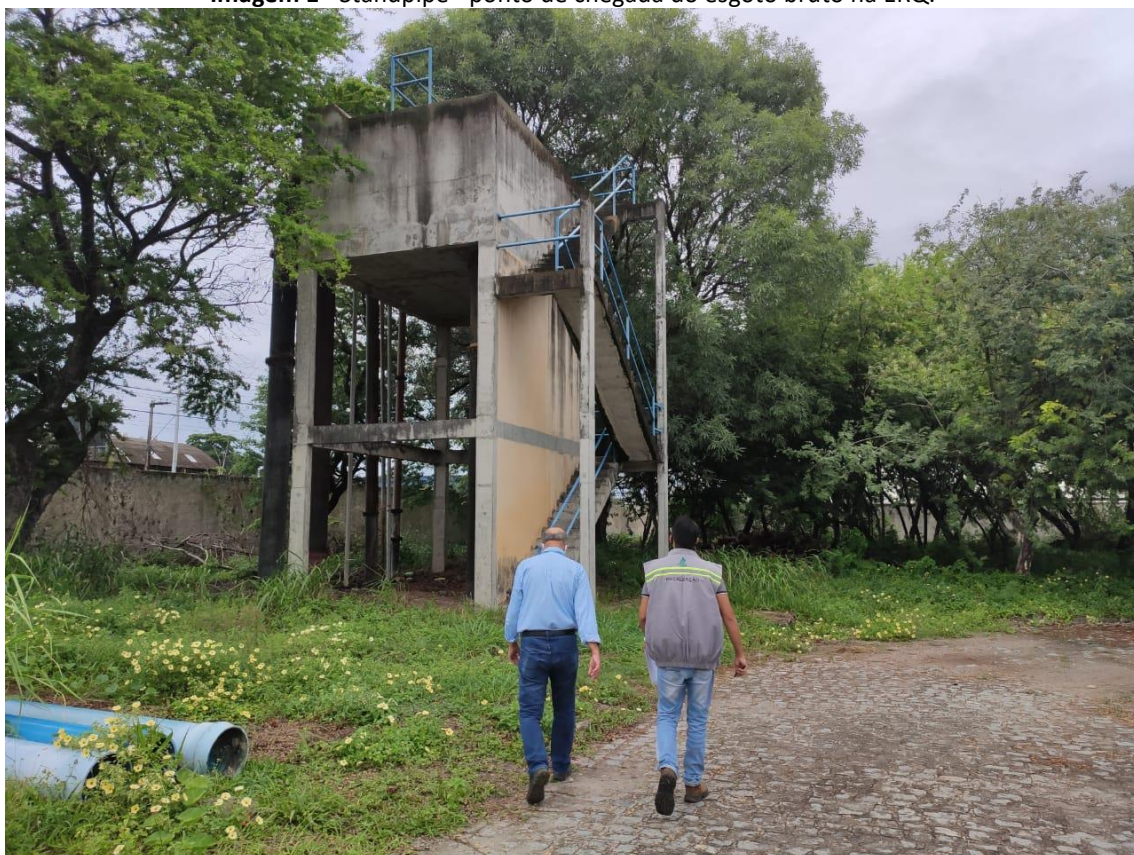
Imagem 1 - Standpipe - ponto de chegada do esgoto bruto na ERQ.
