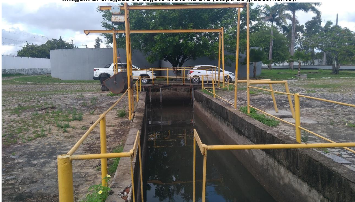
Imagem 1: Chegada do esgoto bruto na ETE (etapa de gradeamento).
