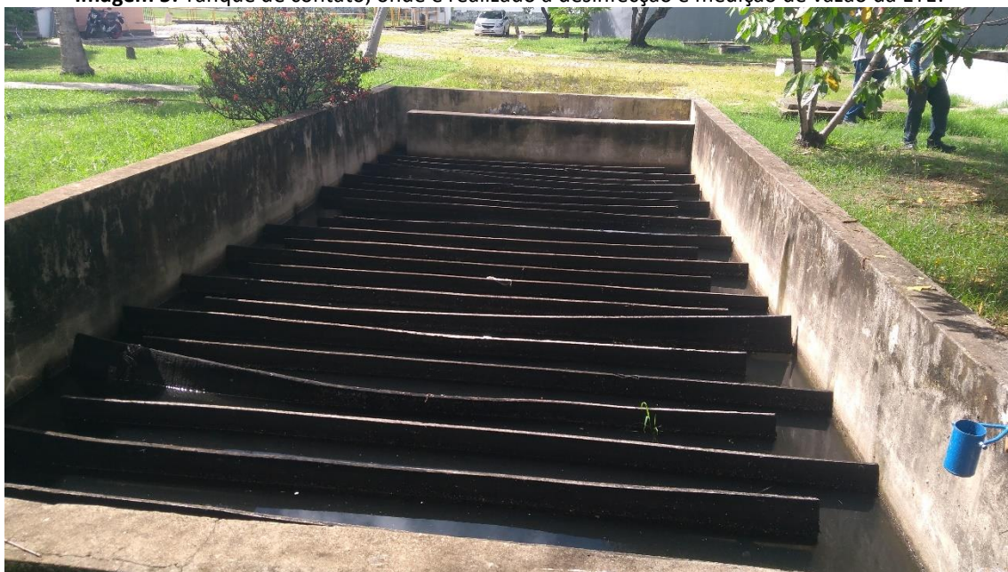
Imagem 5: Tanque de contato, onde é realizado a desinfecção e medição de vazão da ETE.
