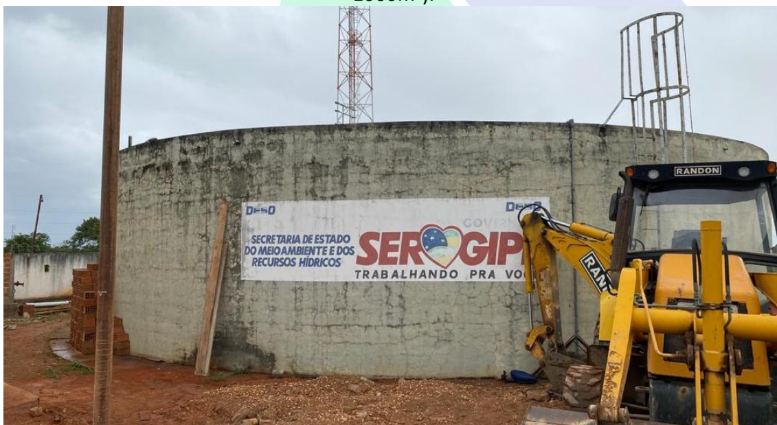
Imagem 4 – Reservatório Apoiado – Semiárido (Capacidade de armazenamento de 1000m 3 ).
