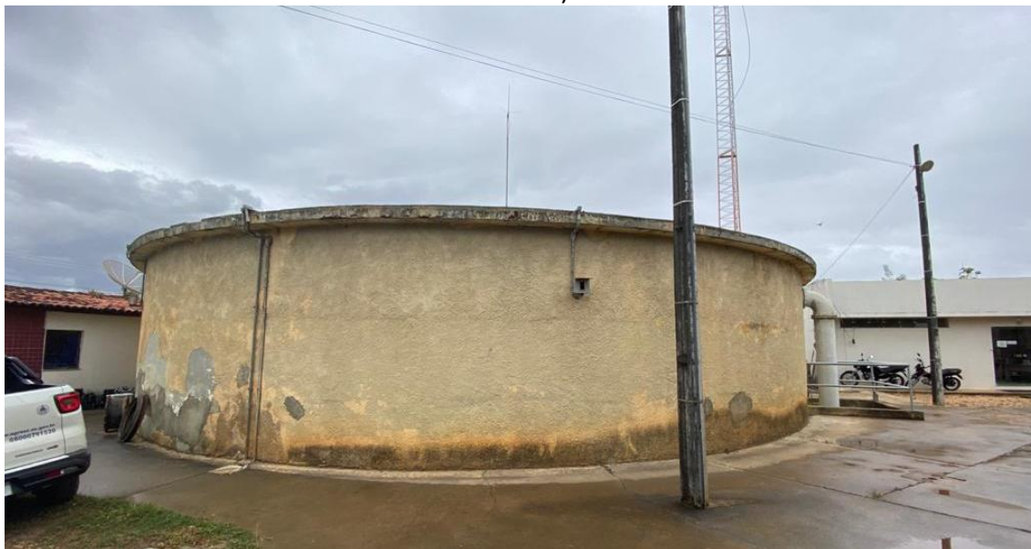
Imagem 3 – Reservatório Apoiado – Sertaneja (Capacidade de armazenamento de 1000m 3 ).
