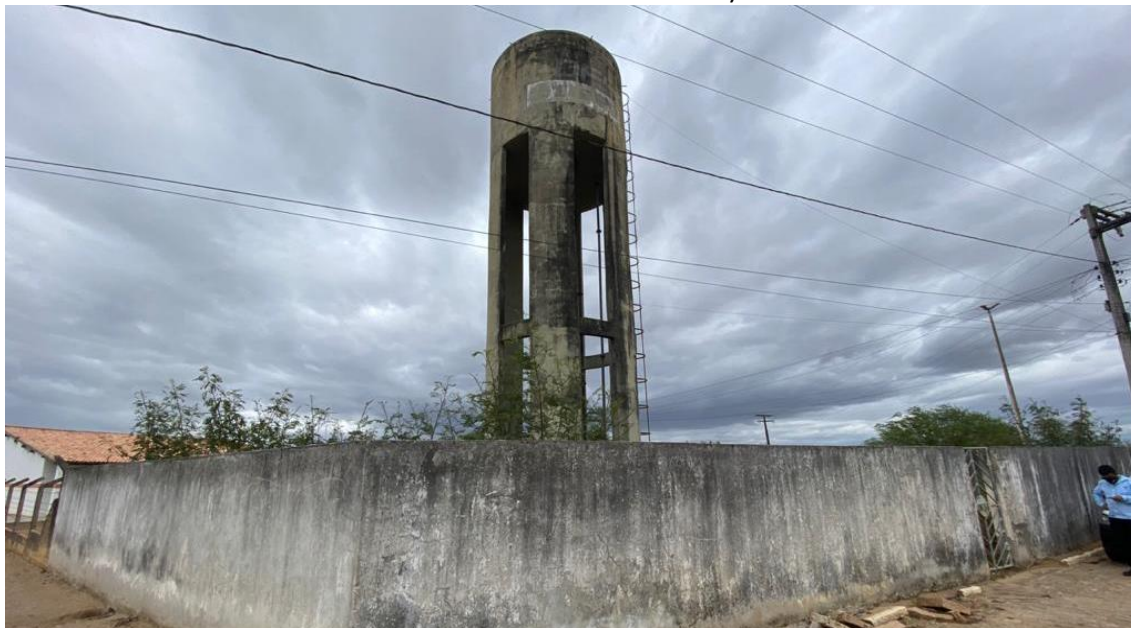
Imagem 5 – Reservatório Elevado – Povoado Fortaleza (Capacidade de armazenamento de 50m 3 ).
