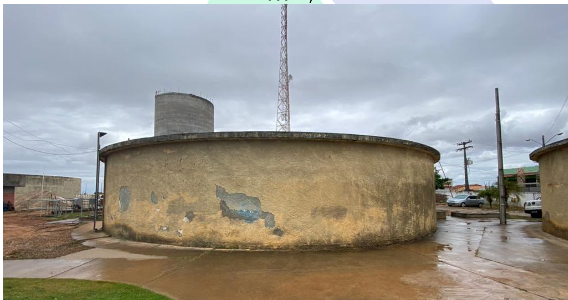
Imagem 2: Reservatório Apoiado – Alto Sertão (Capacidade de armazenamento de 1000m 3 ).
