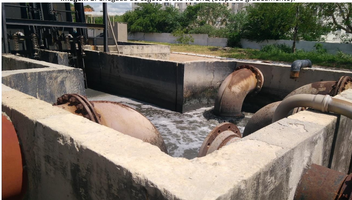
Imagem 1: Chegada do esgoto bruto na ERQ (etapa de gradeamento).
