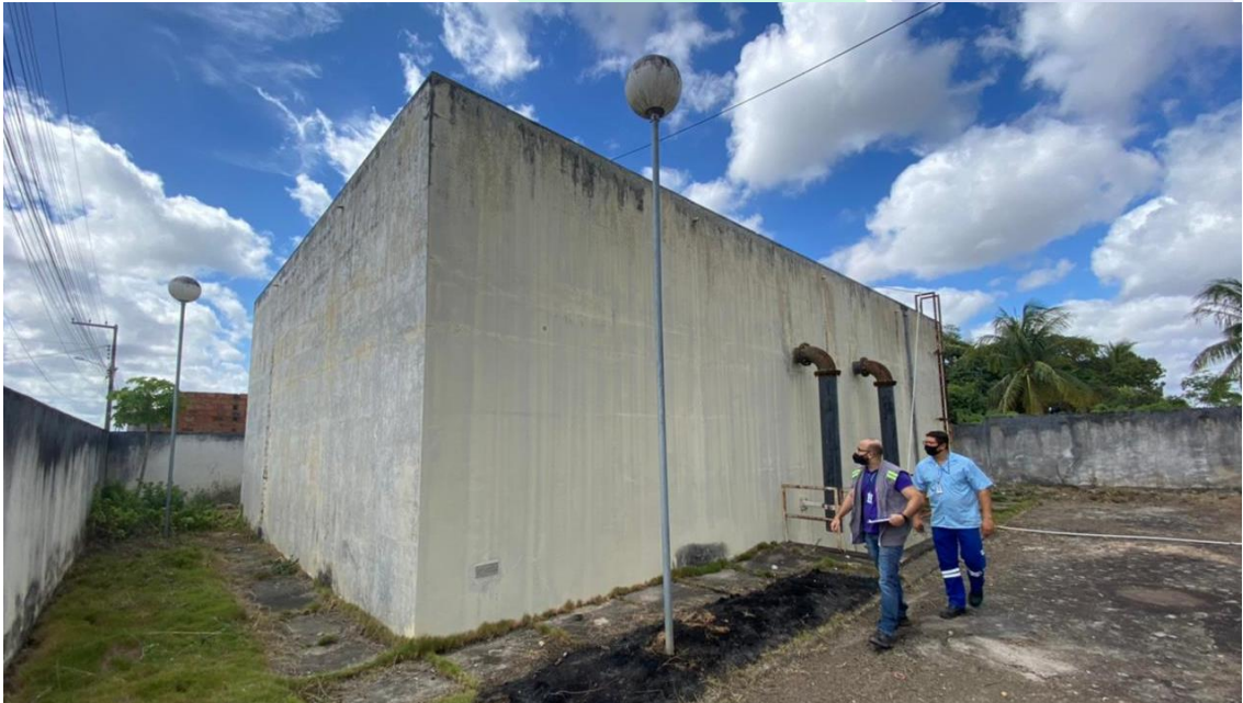
Imagem 2: Reservatório Apoiado – Macambira (Capacidade de armazenamento de 500m 3 ).
