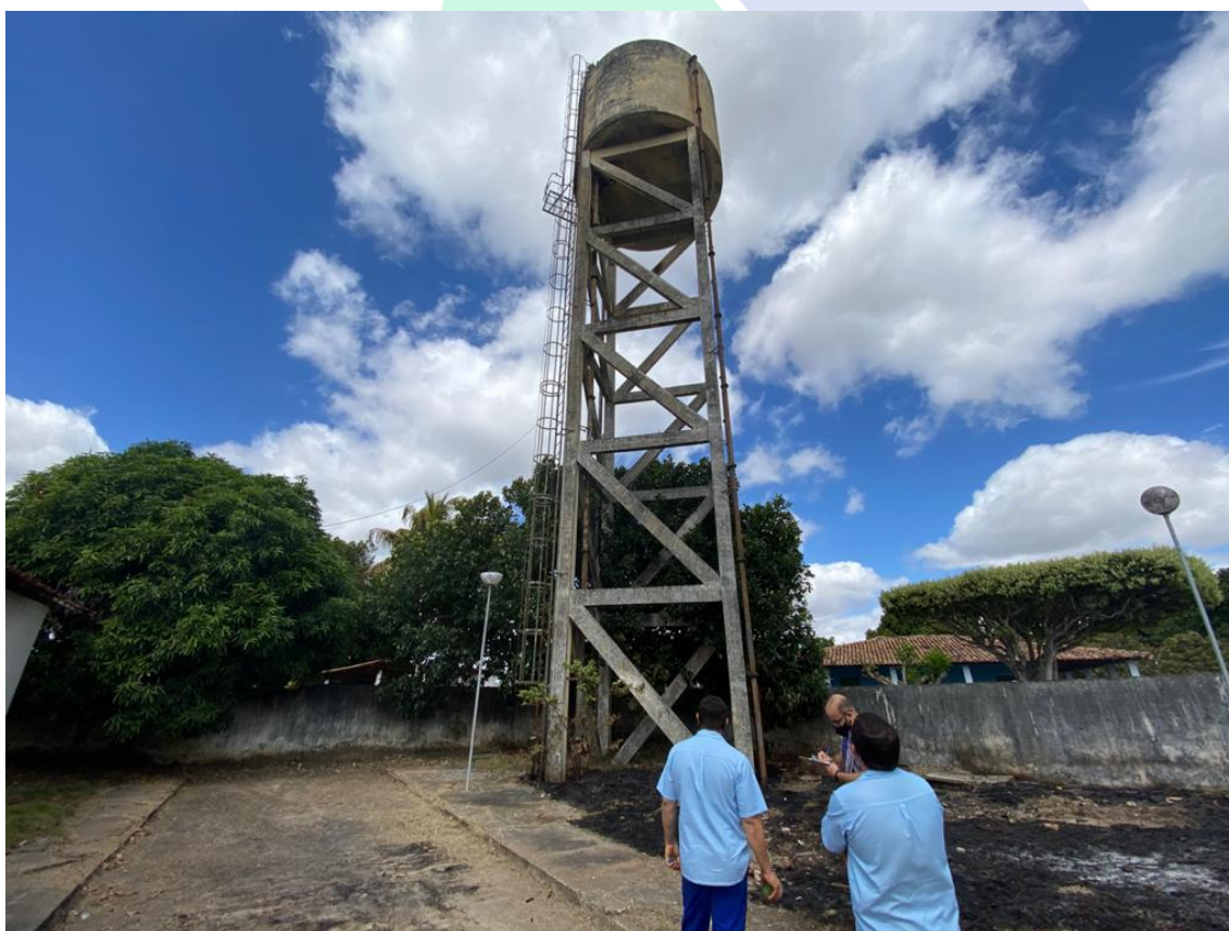
Imagem 4 – Reservatório Elevado – Macambira (Capacidade de armazenamento de 150m 3 ).
