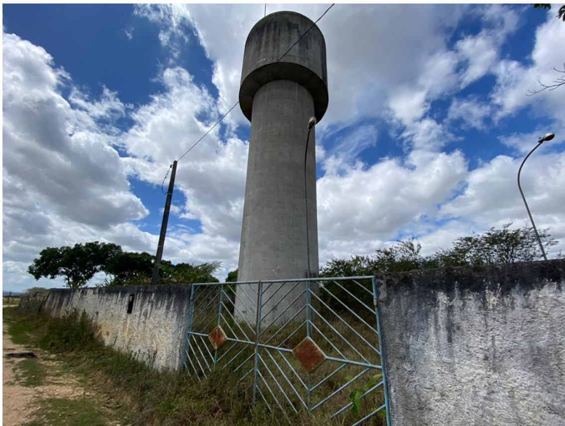
Imagem 5 – Reservatório Elevado – Sobrado (Capacidade de armazenamento de 150m 3 ).
