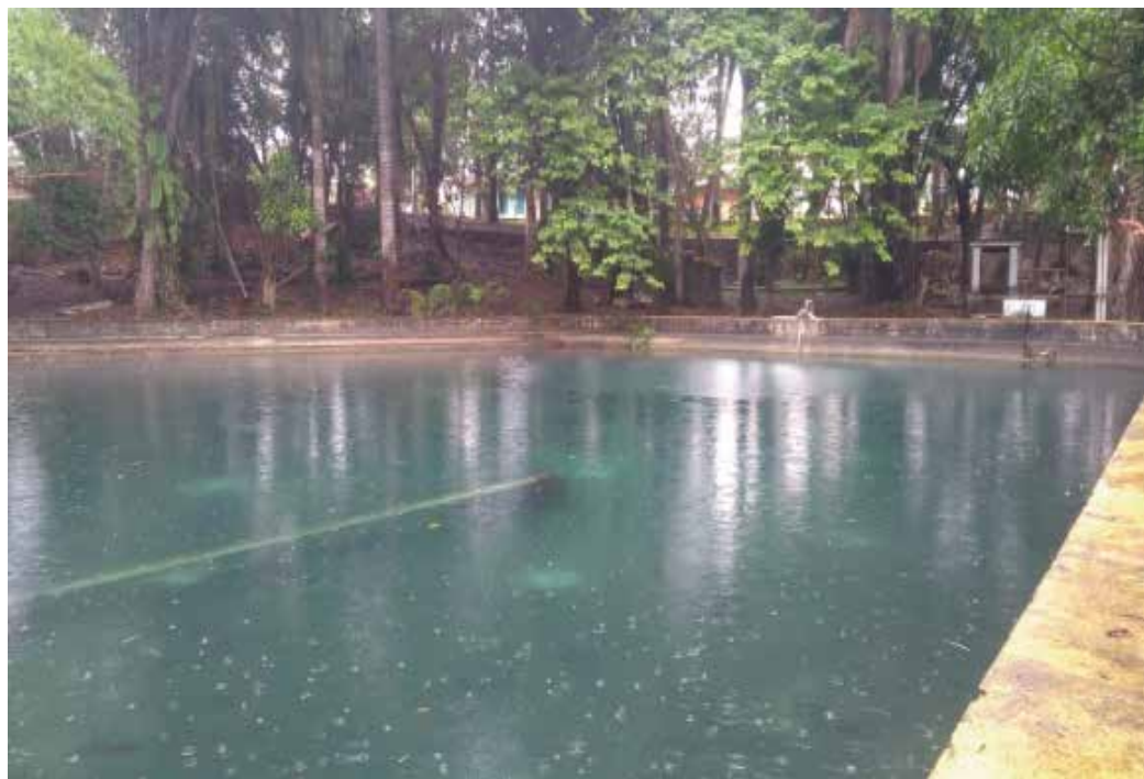
Figura 34: Piscina de captação responsável pelo abastecimento de água do município de Salgado/SE. Fonte: CAMSAN/AGRESE.
