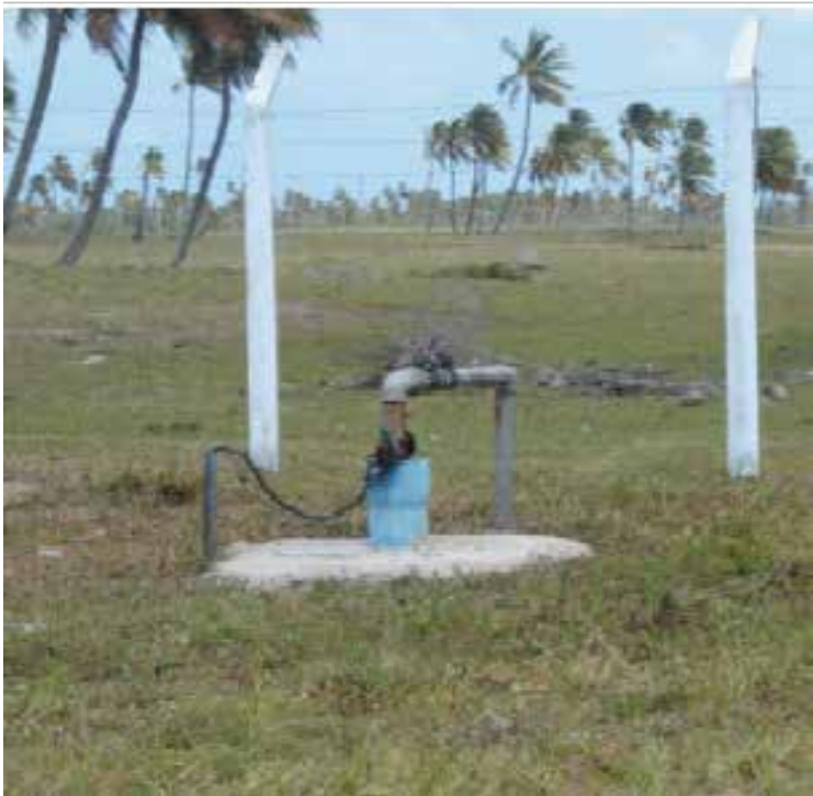
Figura 32: Poço de captação responsável pelo abastecimento da ETA - Caueira. Fonte: CAMSAN/AGRESE.
