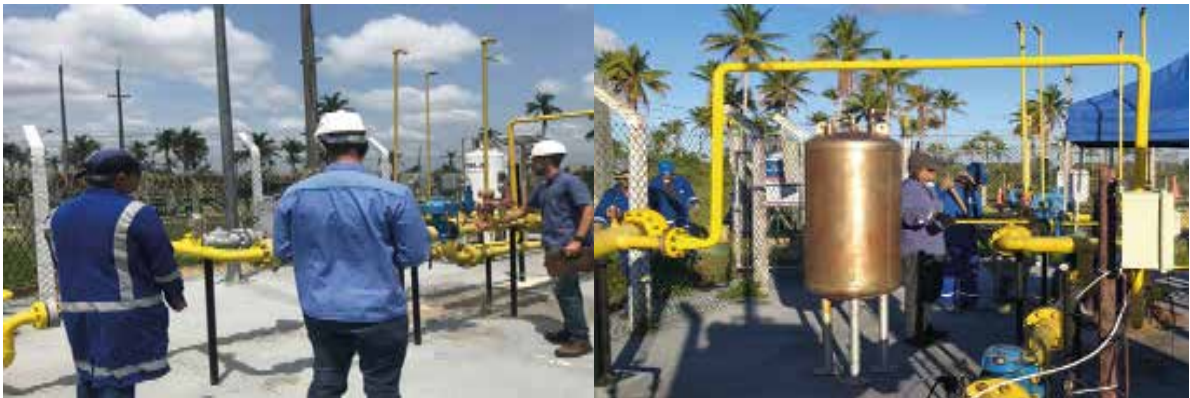
Figura 20: Estação de transferência de custódia Estância-SE. Figura 21: Bypass instalado na ETC Estância-SE. Fonte: CAMGAS/AGRESE.
