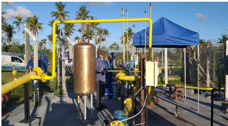
Figura 2: Instalação do bypass
